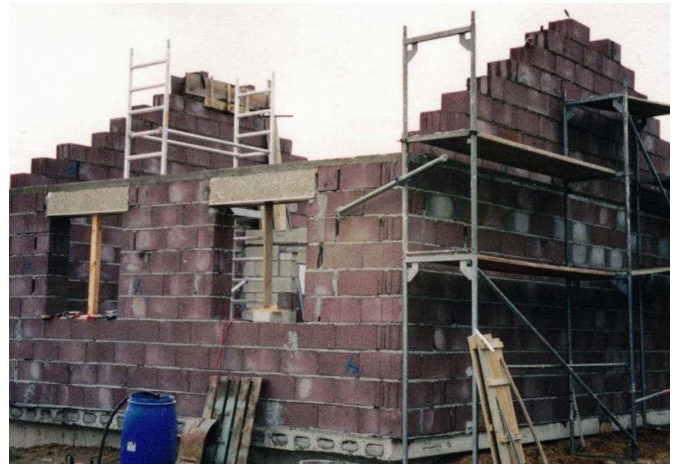
Rohbau im Winter
