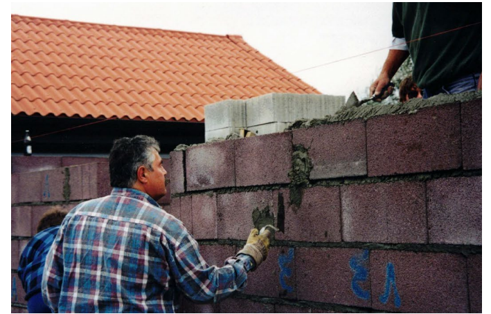
Guck mal, wer da mauert!
