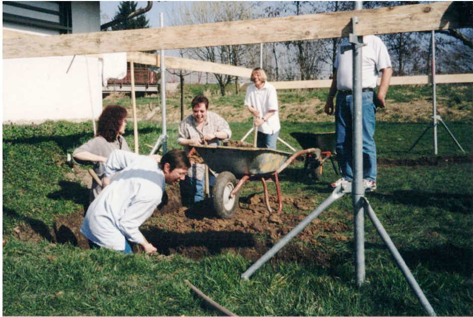
Ausheben des Kellers
